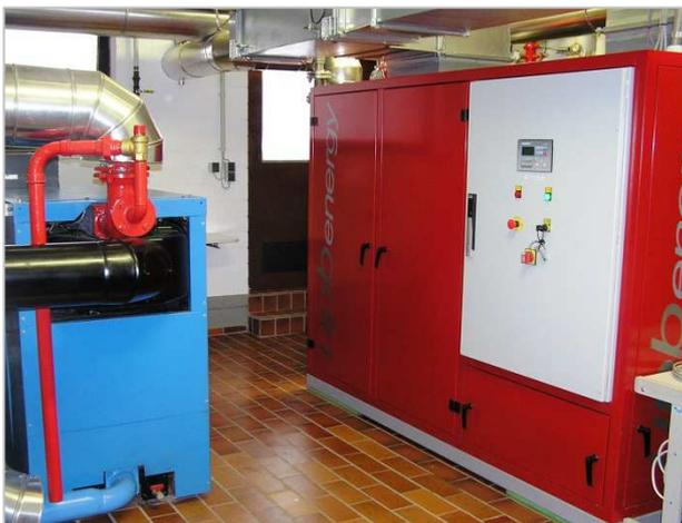
**Bild 8: BHKW-Modul 50 kW**
