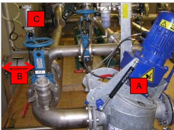
**Bild 5:** Rohschlamm/- Gärsubstratpumpstation
