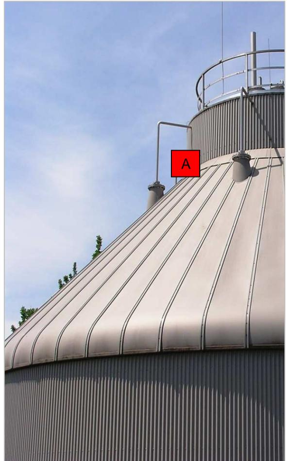
*Bild 7: Gaseinpressslanzen Faulbehälter*
